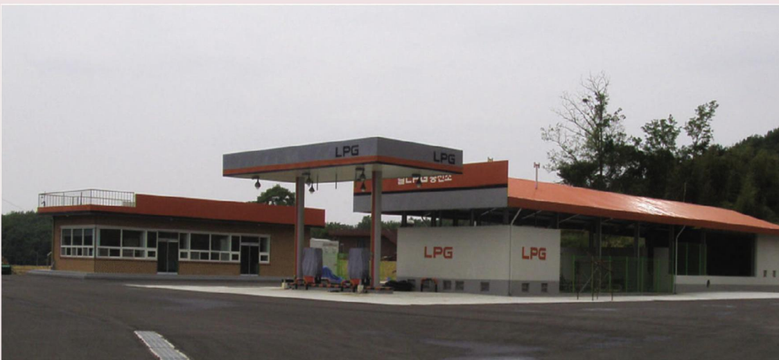
LPG 충전소 시공
