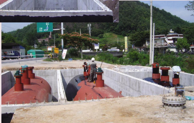
LPG 저장탱크 시공
